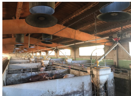
Kettensystem bewegt das Beschäftigungsmaterial von einer Bucht zur nächsten Bucht
