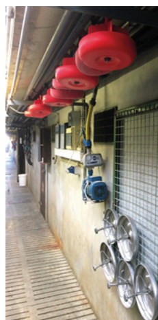
Hængende automater til foder til pattegrise reducerer forurening/tilsmudsning
